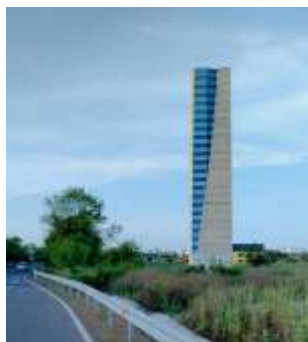
ВХОДЕН ЗНАК БУРГАС мозайка и бетон
